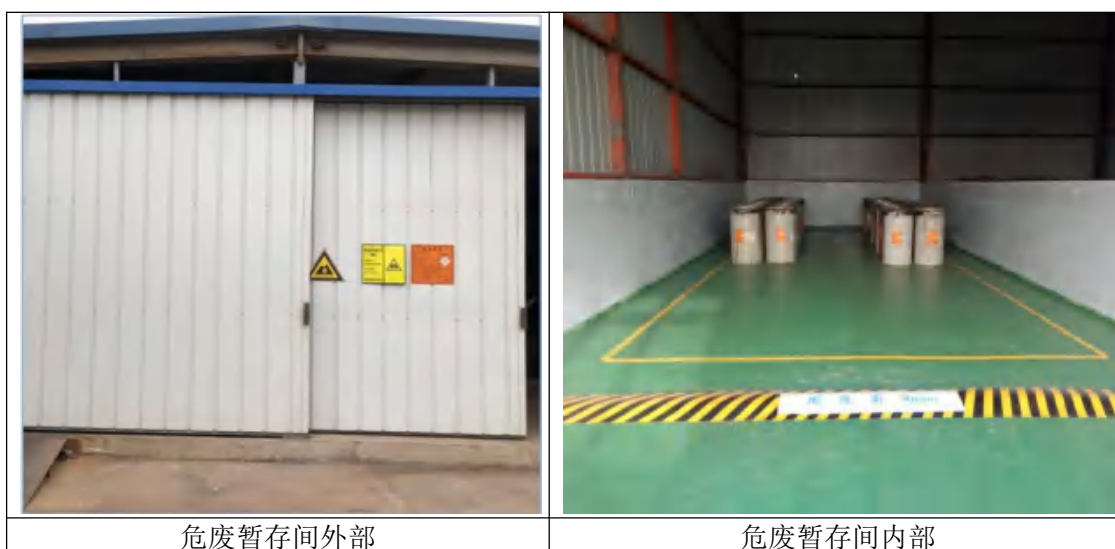
图 2-12 危废暂存间规范化照片
