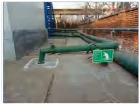
生产废水排放口 DW001
